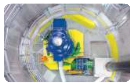
Impianto idroelettrico situato in Valle Maira (CN) gestito da EGO Trade
